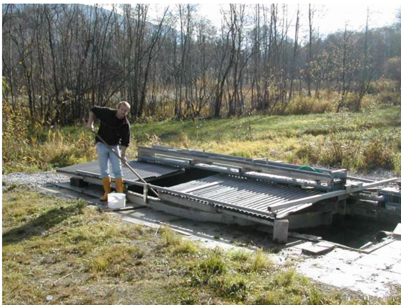
Neu eingebauter Fischbehälter
